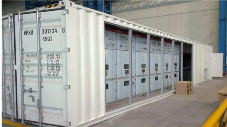
混合式无功补偿装置是由无源型电抗、电容器补偿和有源型 SVG 补偿有机组合在一起的可快速、连续光滑调节电力系统无功功率的新型装置。BW-HFC+SVG 系列装置，是利用 IGBT 技术、SVG 技术、电力电子技术、LC 补偿滤波技术等多种技术融合，其原理为根据采样电路的交流采样分析出负荷无功情况，HFC 部分作为基本的补偿，SVG 部分进行精确调整，实现负荷无功平滑调节的装置。产品广泛应用于冶金、煤炭、化工、有色、石化、半导体、汽车等行业。
